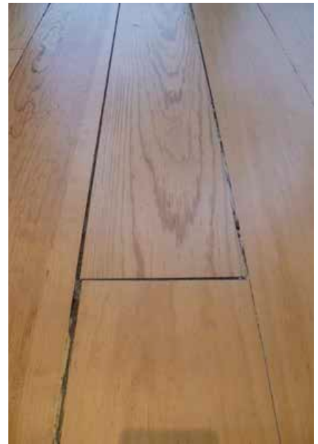
Wird bei Plankenware bei der Verlegung nicht sauber „auf Stoß“ gearbeitet, zeigen sich schnell offene Fugen.
