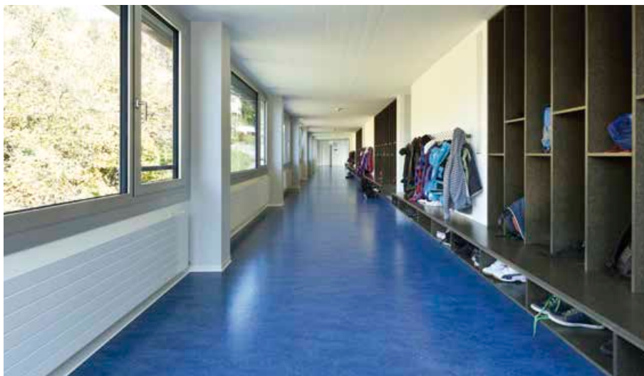
Eine Grundreinigung und anschließende Neueinpflege lässt alte und verkratzte Linoleumböden wieder in neuem Glanz erstrahlen.
